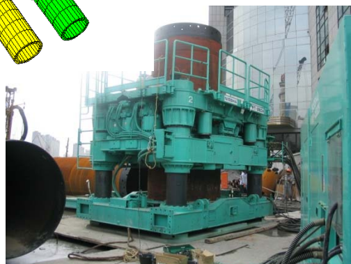
上海轨道交通7号线5标段区间
