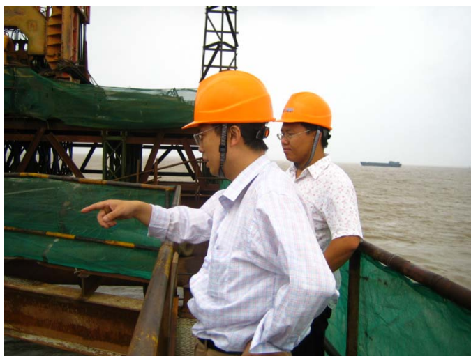
东海大桥大体积混凝土的裂纹控制
