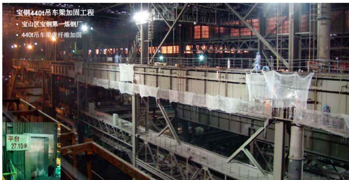
上海宝钢 440T 吊车梁加固工程
